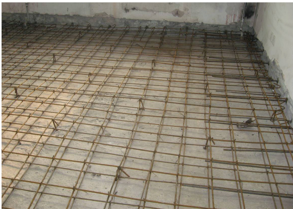
混凝土结构构件叠合层加固
