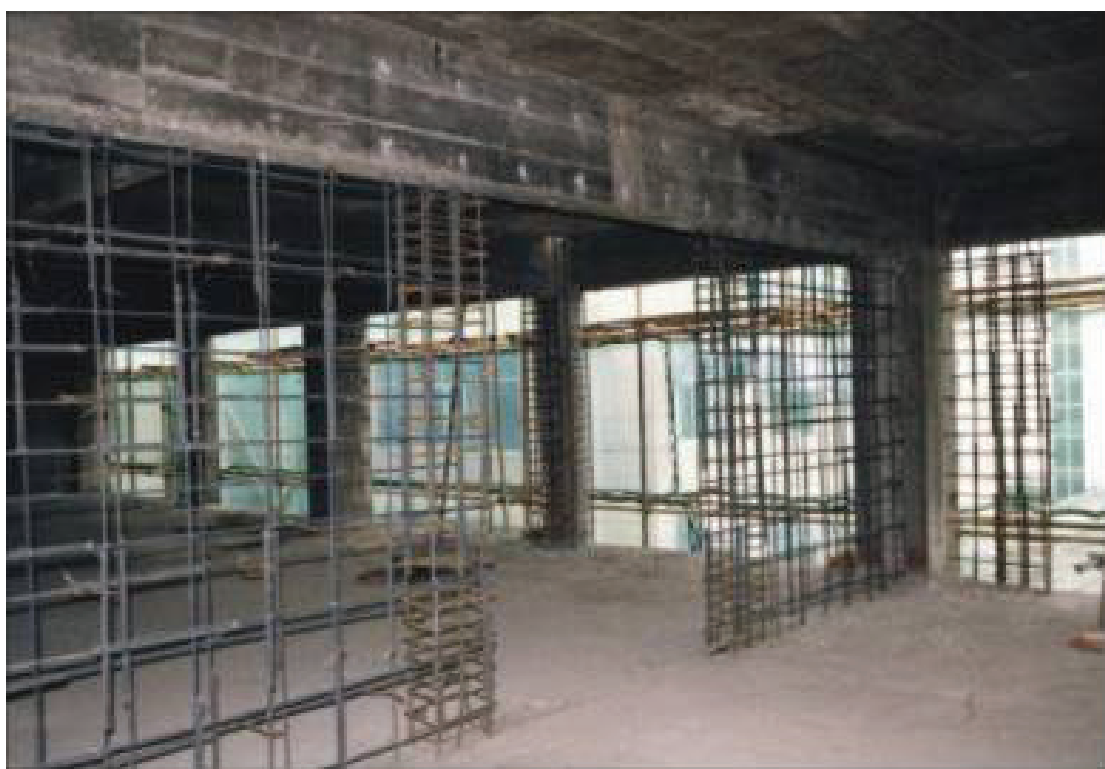
混凝土结构增设剪力墙加固
