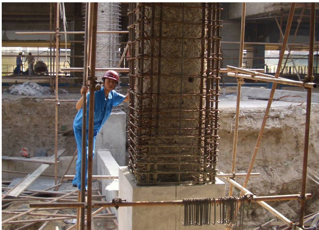
混凝土结构构件柱增大截面加固
