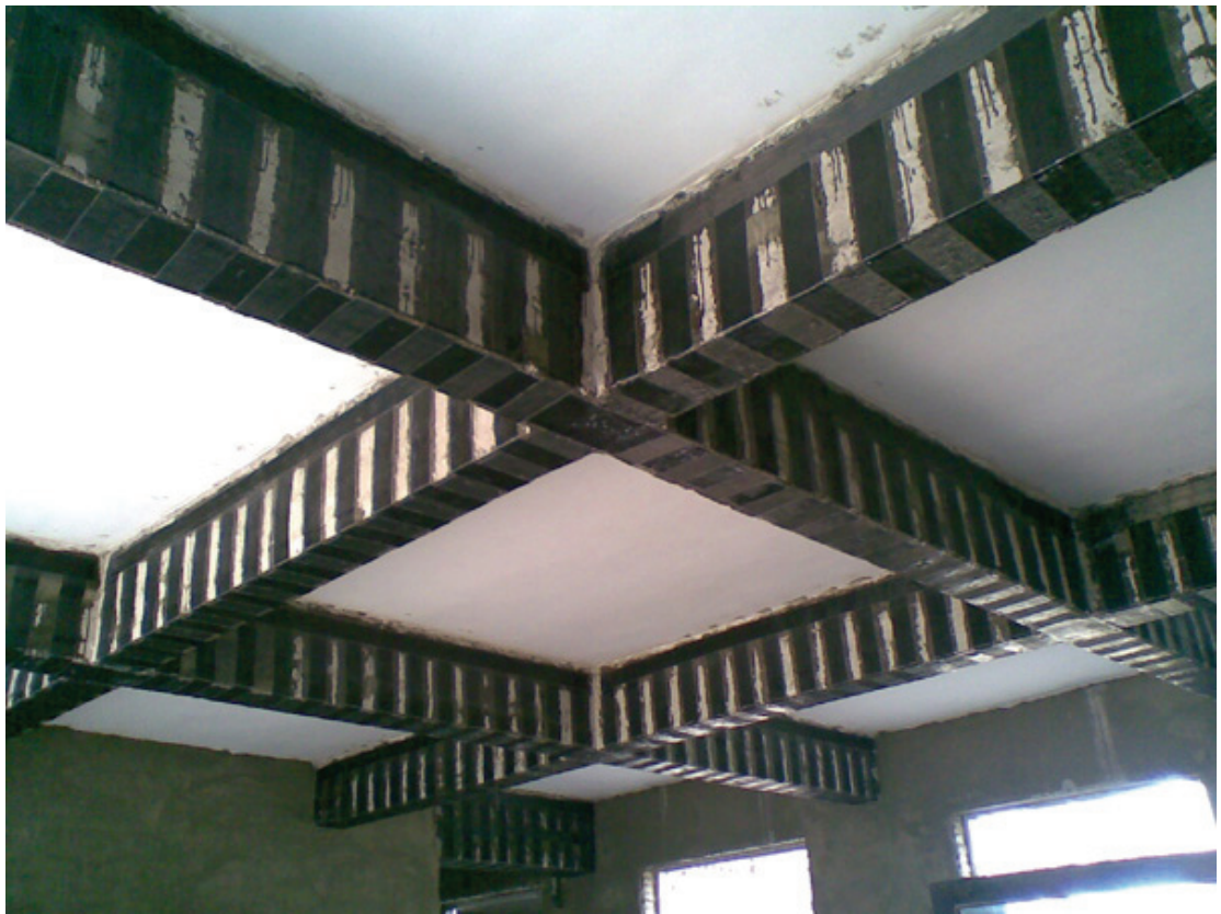
混凝土结构构件碳纤维加固
