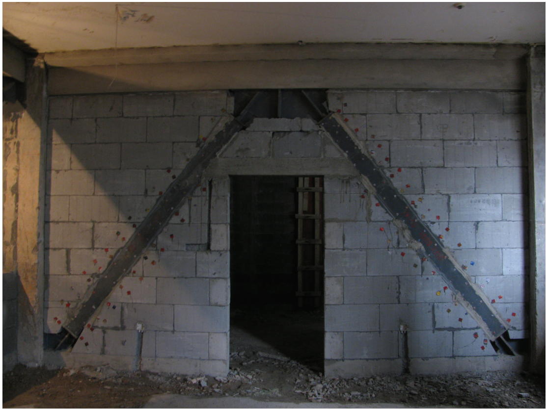
混凝土结构增设阻尼加固
